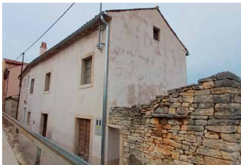
La facciata anteriore appena restaurata
