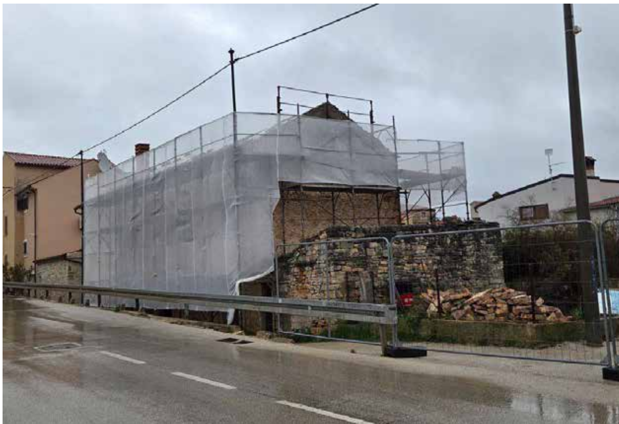
Istantanea in pieno restauro della futura Casa galifaneša - facciata anteriore
